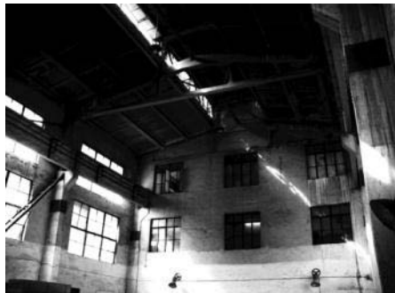
▲ 8号桥I期 1号楼改造前
