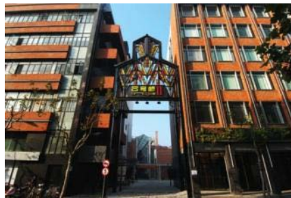
▲ 8号桥II期：局门路436号
