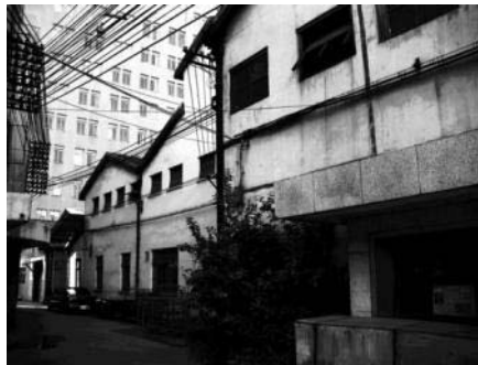
▲ 8号桥I期 5号楼改造前
