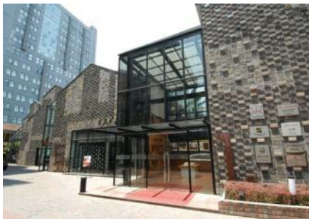
▲ 8号桥I期 5号楼改造后
