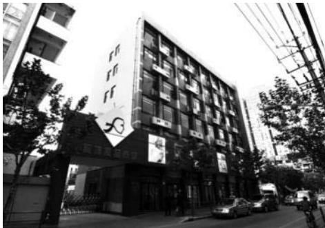
▲ 8号桥II期 1号楼改造前
