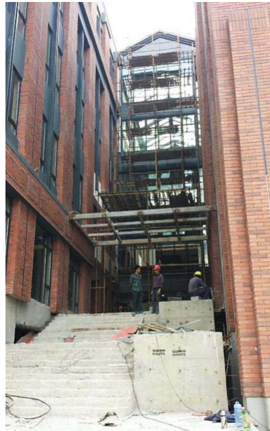
改造现场照片 ►
